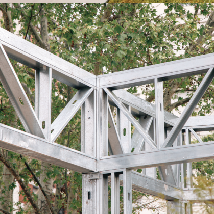
Obra en steel framing : Pabellón Ternium en el Museo de Arquitectura y Diseño - Ciudad de Buenos Aires.
